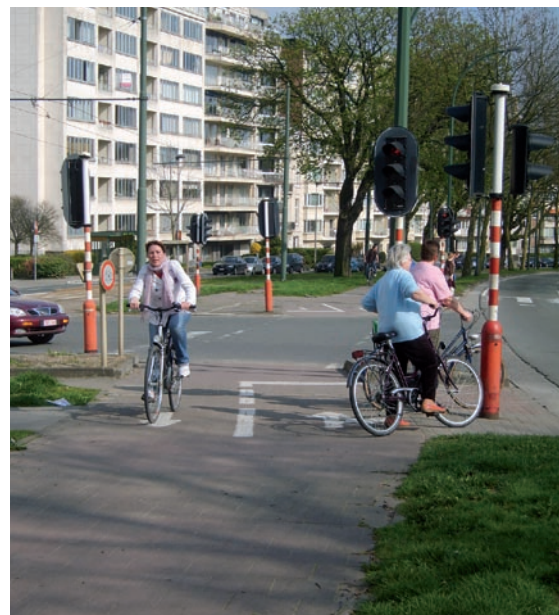
Piste cyclable séparée bi-directionnelle en dalles de béton
