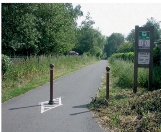
Piste cyclable en revêtement bitumineux
