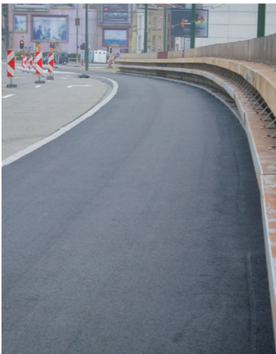
Cette piste cyclable en revêtement bitumineux neuf offrira un excellent confort de roulement
