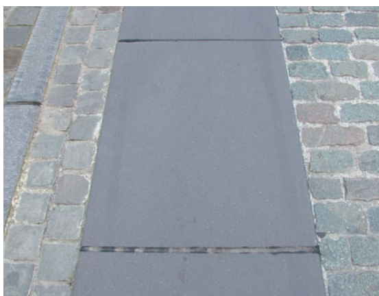
Bandes confort en béton basalte
