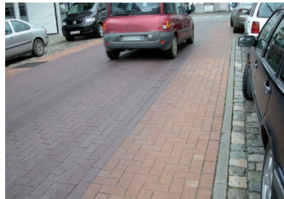
Chaussée en pavés de béton : bonne lisibilité de l'espace de circulation
