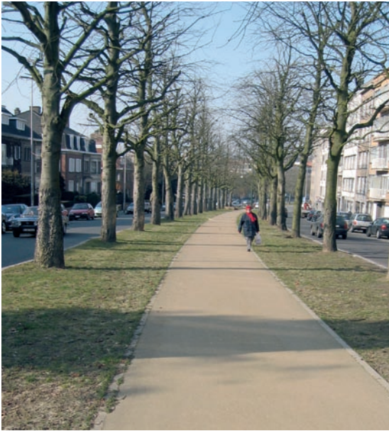
Revêtement bitumineux coloré (zone piétonne)
