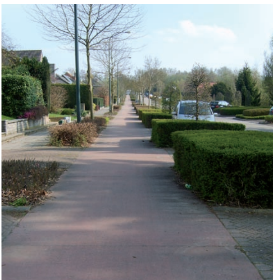
Piste cyclable séparée en béton
