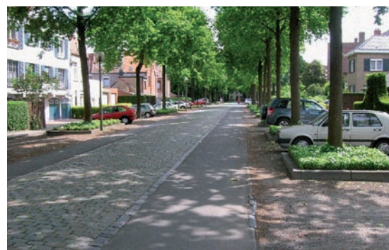
Deux bandes confort en asphalte
