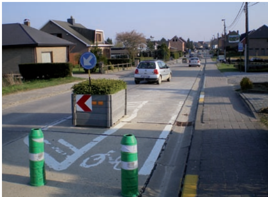
Chicane avec passage latéral pour les cyclistes
