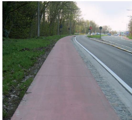
Piste cyclable séparée en béton rouge
