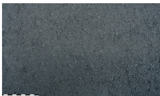
Béton bitumineux BB-5
