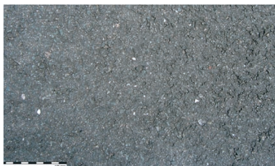
Béton bitumineux BB-4
