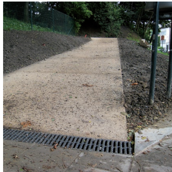
Béton désactivé pour les rampes d'accès à la promenade du chemin de fer à Woluwe
