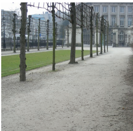
Chemin en dolomie. Ce matériau n'est pas recommandé pour les aménagements cyclables
