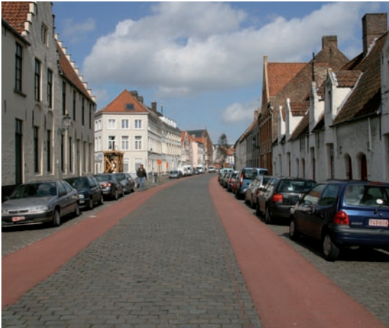
Deux bandes confort en MBCF
