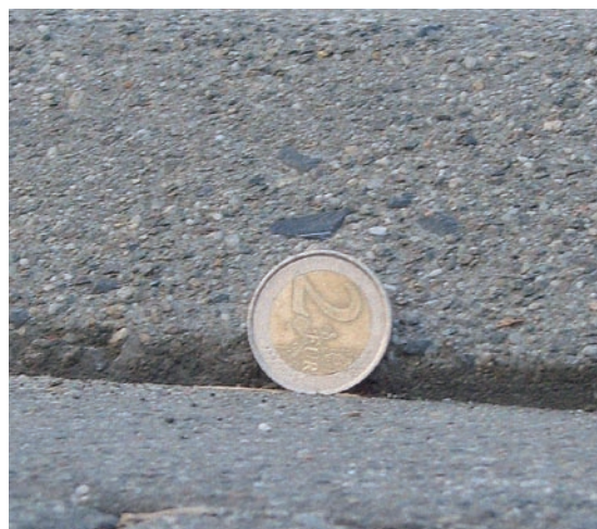
Le test de la pièce de 2 euros (diamètre de 2,5 cm) permet de mettre cet obstacle en évidence
