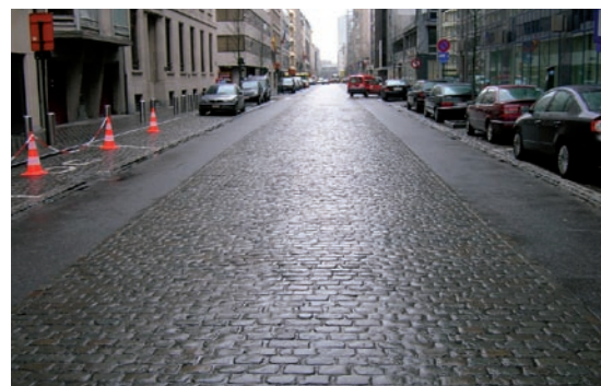
Deux bandes confort en asphalte avec fondation propre
