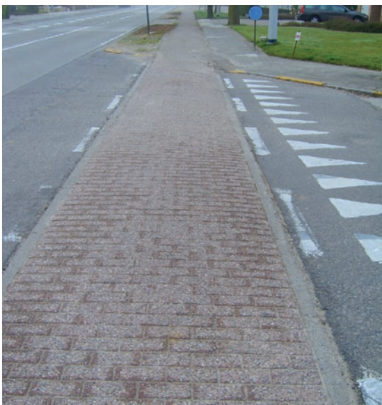
Continuité de la piste cyclable séparée en pavés de béton au droit d'une traversée de rue latérale
