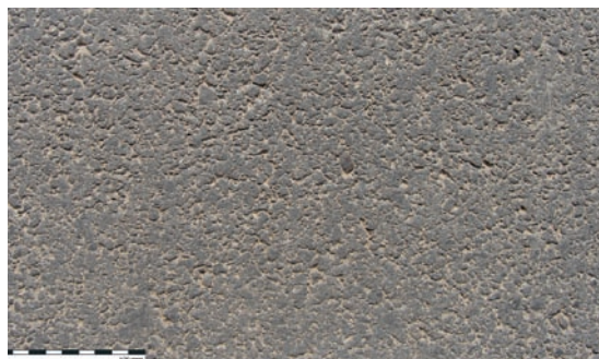
Béton bitumineux BB-1B
