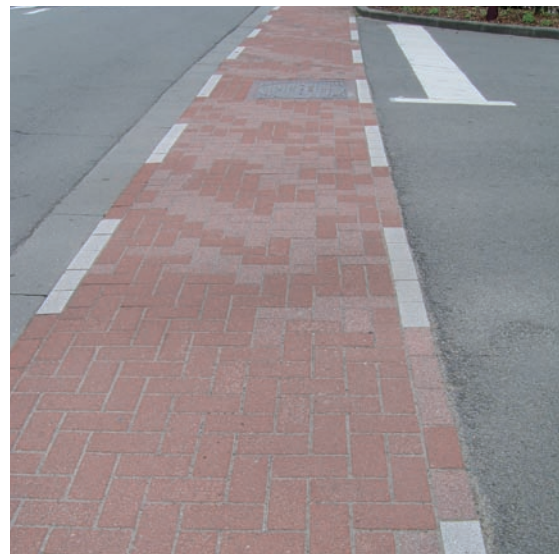
Traversé en pavés de béton rouges avec marquages en pavés blancs
