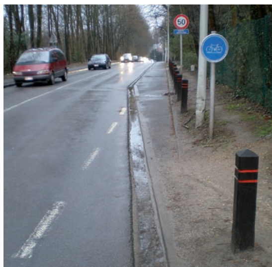
Le filet d'eau et la bordure rendent cette insertion dangereuse
