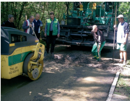
Mise en œuvre d'enrobé écologique
