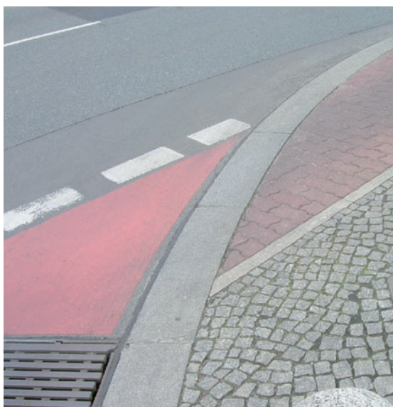
Accès sans filet d'eau et avec bordure enterrée
