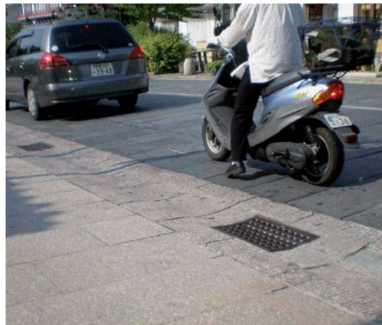
Filet d'eau préfabriqué en béton à profil transversal concave
