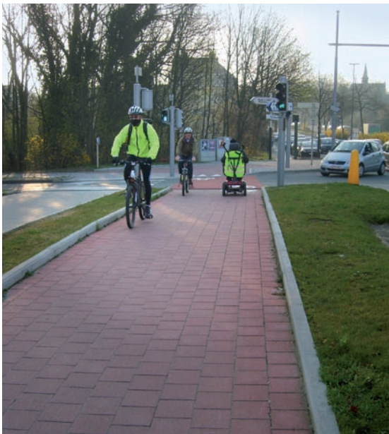
Traversée de terre-plein central à niveau avec revêtement en dalles rouges
