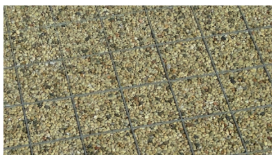
Structure drainante avec plaques alvéolaires synthétiques et gravillons devant l'ambassade américaine à Bruxelles
