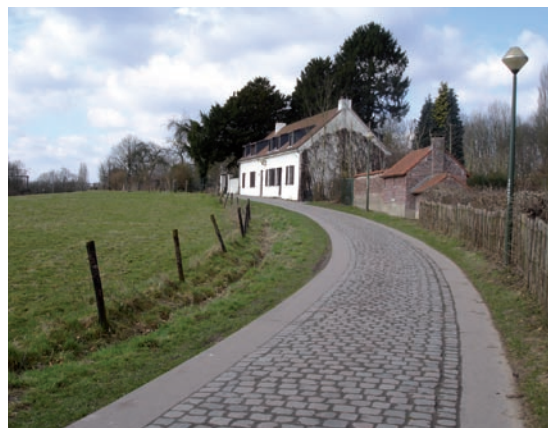
Bande confort en béton sur le trajet de la Promenade verte autour de Bruxelles
