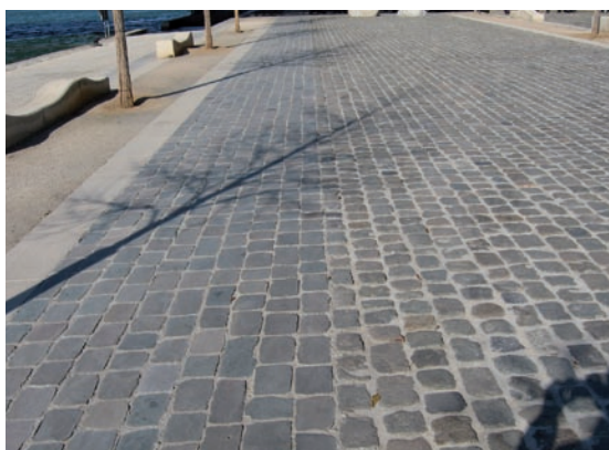
Bande confort en pavés sciés sur chaussée en pavés classiques
